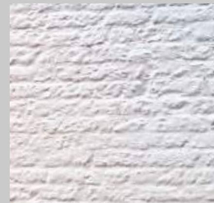
bestaande witte muren vd kerk
